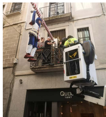
FIGURA 11. Instal·lació del sistema final al carrer de l'Argenteria. FONT: Elaboració pròpia.
